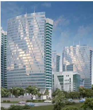
LCD flotila bytové domy, Moskva, Rusko
